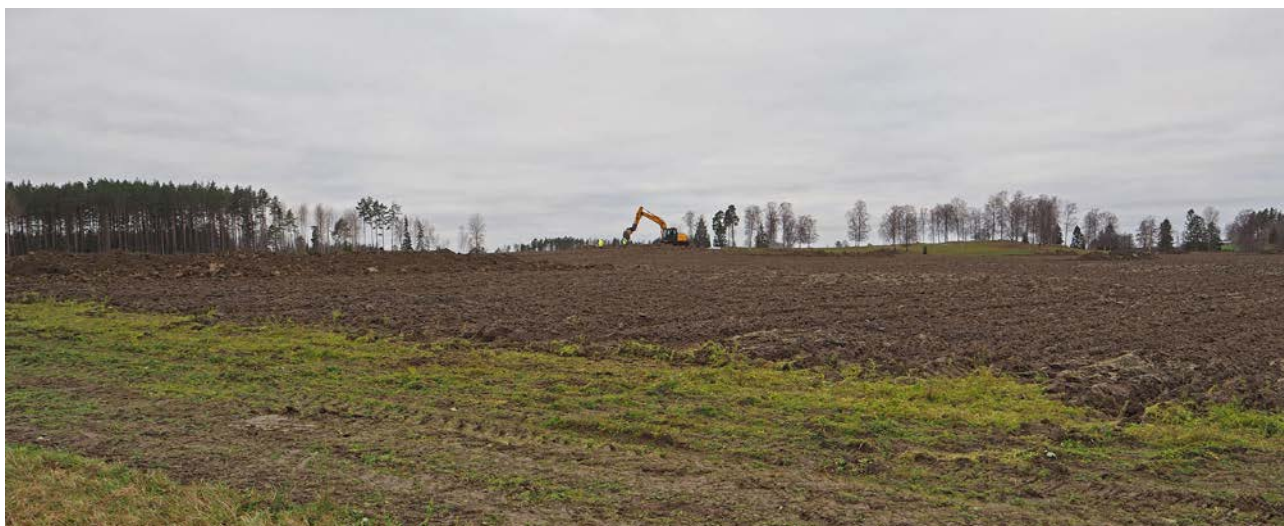
FIGUR 18. Schaktningsarbete inom undersökningsområde 1. Från sydöst. Foto: Ann Lindkvist.
