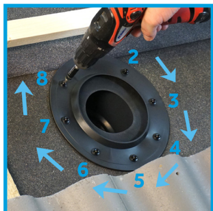
Skruva fast flexslangens underbeslag mot underlagstaket. OBS! skruva endast i skruvarna till hälften första varvet.
