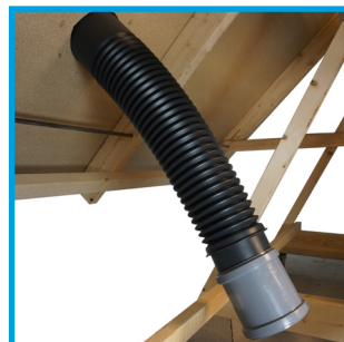
Anslut flexslangen till luftningsledningens G-ringsmuff.
