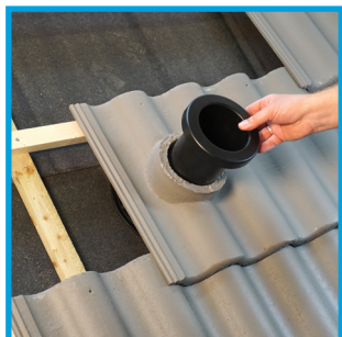
Återmontera kragröret.
