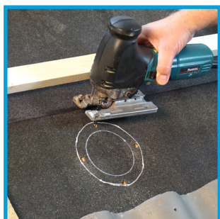
Gör håltagning i underlagstaket efter den yttre markeringen
