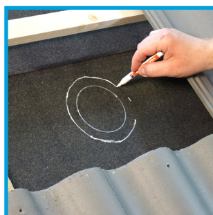
Rita av kragröret invändigt mot underlagstaket
