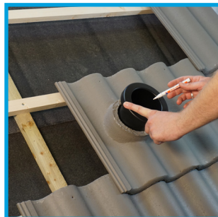
Rita av kragröret invändigt mot underlagstaket
