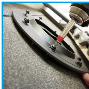
Skruva sedan ner samtliga skruvar så att gummipackningen komprimeras jämnt runtom.
