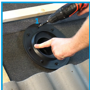
Skruva fast flexslangens underbeslag mot underlagstaket. OBS! skruva endast i skruvarna till hälften första varvet.
