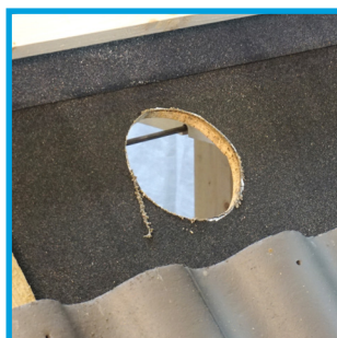
Gör håltagning i underlagstaket efter den yttre markeringen
