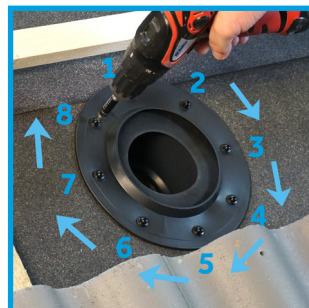
Skruva sedan ner samtliga skruvar så att gummipackningen komprimeras jämnt runtom.
