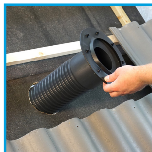
För in flexslangen i hålet.
